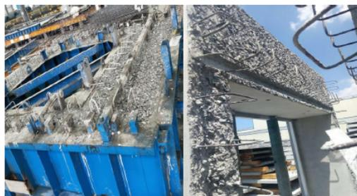
图 2 构件粗糙面成型现场图
